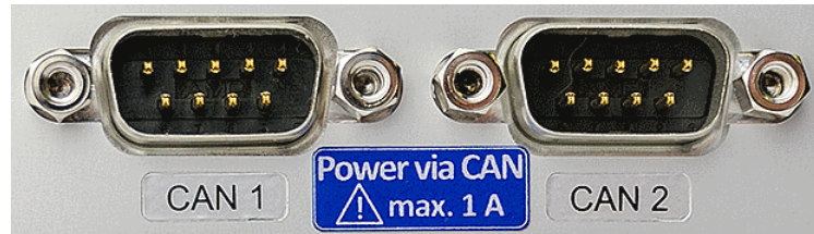
Die Anschlüsse werden entsprechend beschriftet.
